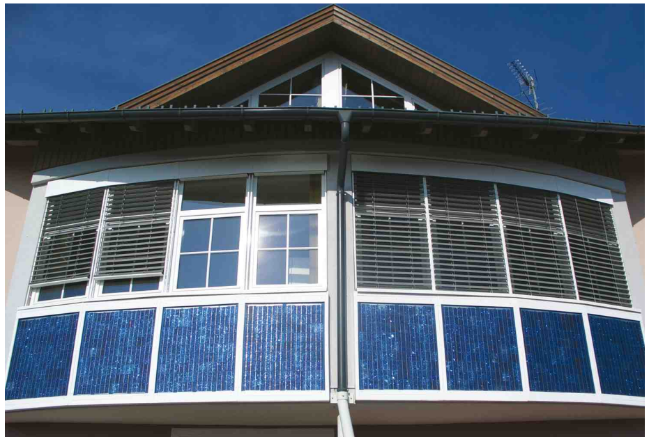
Mit Sonnenkraft läßt sich nicht nur Wärme sondern auch Strom erzeugen. Photovoltaik-Module können ebenfalls gut in die Fassaden integriert werden.
