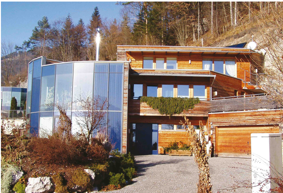
Solarmodule lassen sich nicht nur auf dem Dach anbringen, sondern wie in diesem Beispiel auch in die Fassade integrieren. (Bild: Austria Solar)
