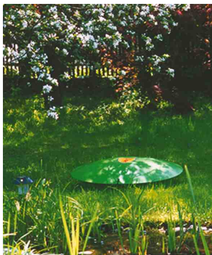
Ein kleiner Deckel ist alles, was vom Flüssiggastank sichtbar bleibt.
